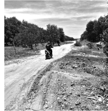
● Dự án còn hơn 1,1km chưa hoàn tất GPMB.
