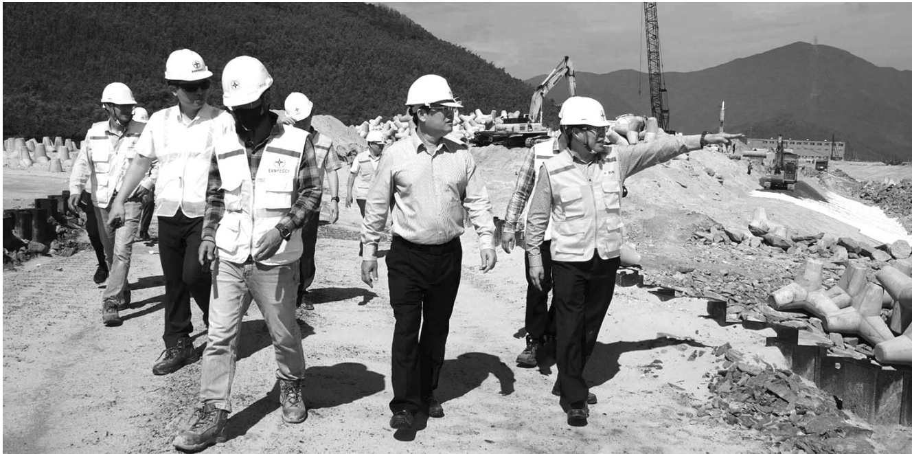
● Lãnh đạo EVN kiểm tra tiến độ Nhà máy nhiệt điện Quảng Trạch 1. (Ảnh: EVN)
