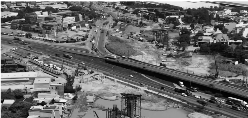
● Nút giao thông Tân Vạn thuộc Vành đai 3 TP HCM - một trong những nút giao lớn và phức tạp của dự án.
