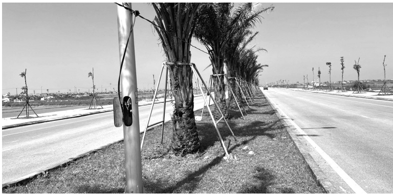
●Khoảng 1,4km dây cáp điện ngầm tại đường Phú Mỹ - Thuận An (TP Huế) bị trộm cắt chỉ trong một đêm. (Ảnh: Thùy Nhung)
