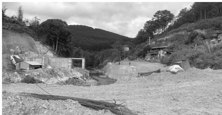
● Dự án tạm dừng thi công trong thời gian dài do vướng mắc về thủ tục nay đã được tháo gỡ.
