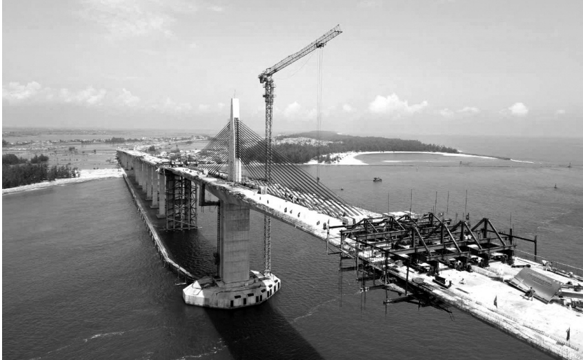
● Tuyến đường ven biển và cầu Thuận An vượt cửa biển sau khi hoàn thành sẽ mở ra cơ hội phát triển hạ tầng du lịch, dịch vụ, các khu nghỉ dưỡng cao cấp.
